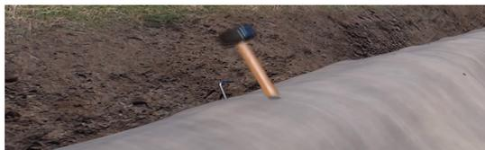
**Рисунок 5. Закрепление бетонного полотна кольями в анкерных пазах**
