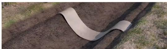
**Рисунок 4. Укладка бетонного полотна с установкой краёв в анкерные пазы**
