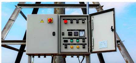
**Рисунок 3. Панель управления дождевальной машиной**
